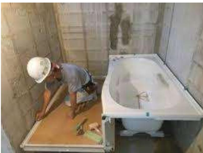
図 5-1: 浴槽、床設置工事中
