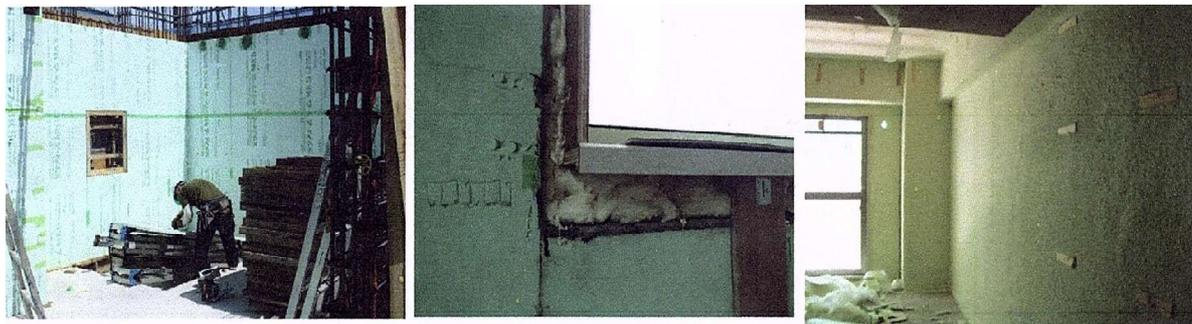
図 4-1:断熱材施工
