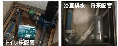
す。B組合では、ガス管、追炊き管まで含めています。工法は、B組合が全部更新で、A、C組合は更新・更生の併用です。
