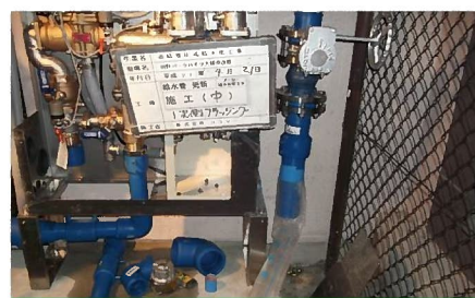
直結増圧ポンプユニット設置
